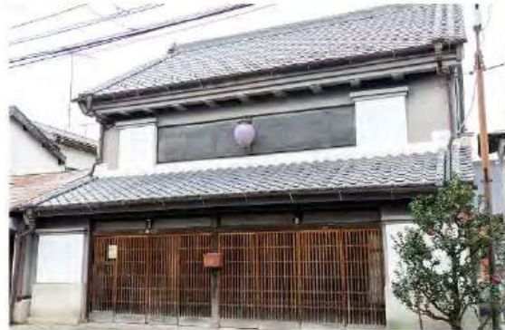
明治中期の建築された乾物屋の見世蔵、磯田邸
